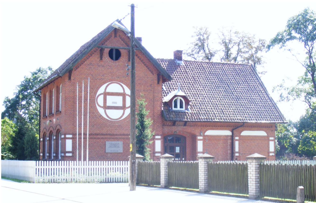
fot. budynek b.szkoły z 1906 r. w stanie obecnym
